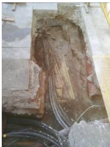
Fig.17.- Rasa 200: diverses vistes dels treballs .Aparició xarxa elèctrica actual i nova escomesa
